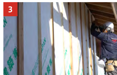
3 透湿防水シート張りと同縁の施工
