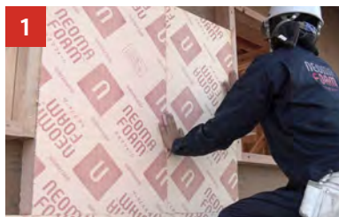
1 ネオマフォーム施工
